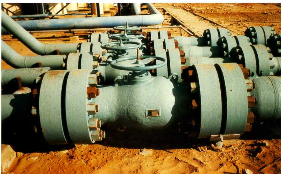
Отсечные клапаны 12" ANSI 2500 фунтов, водоинжекторный трубопровод на нефтяном промысле в Алжире.
