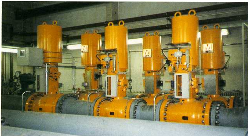
Регулирующие клапаны давления 20" ANSI 600 фунтов, предохранительные отсечные клапаны 16" ANSI 600 фунтов, измерительно-регулирующая станция, Германия.
