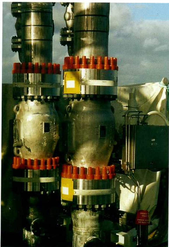
Проходные дроссельные клапаны 10" ANSI 1500 на месте добычи, FPSO, Норвегия
