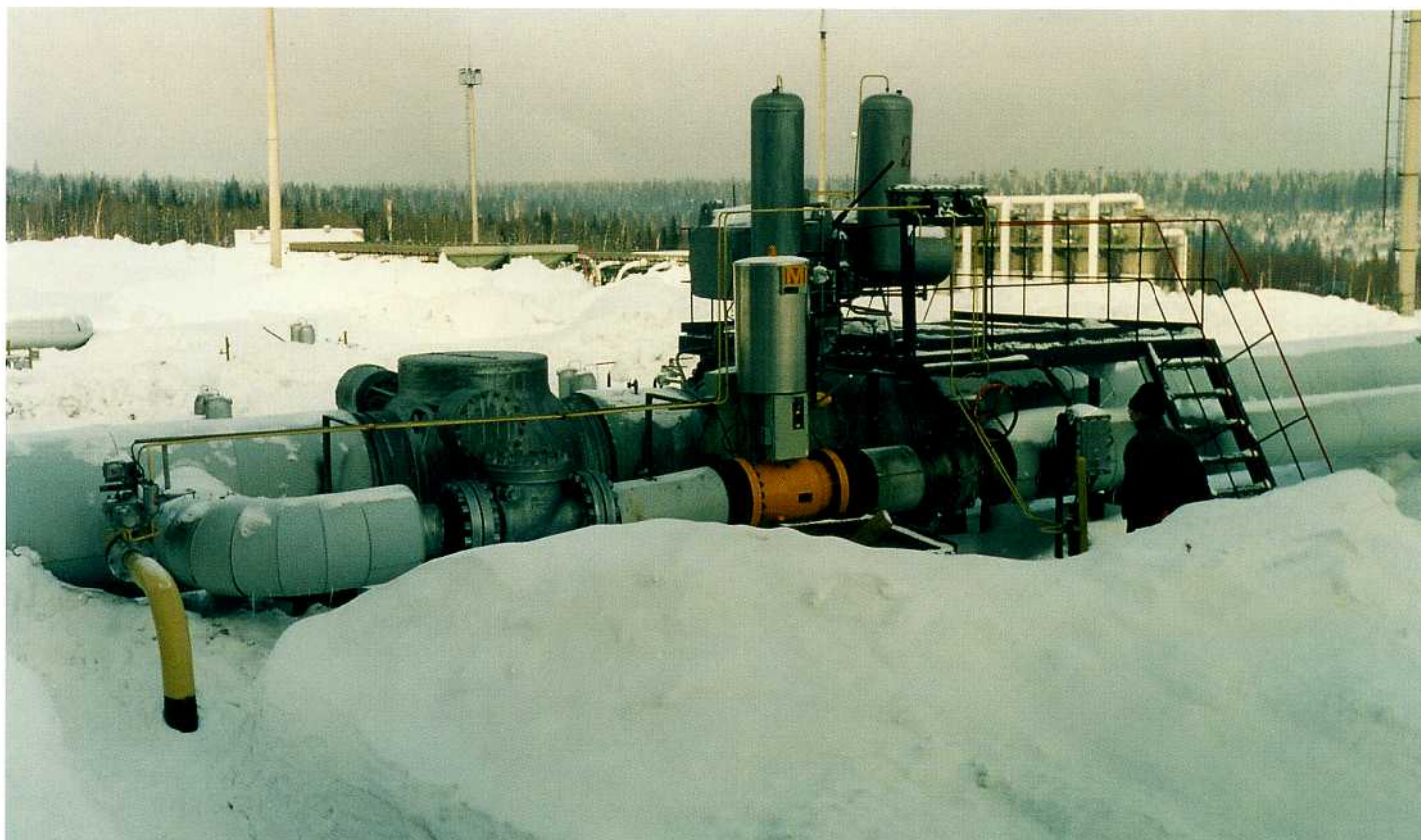
Отсечные клапаны на шлейфах установки добычи газа, Нидерланды (фото любезно предоставлено компанией NAM)
