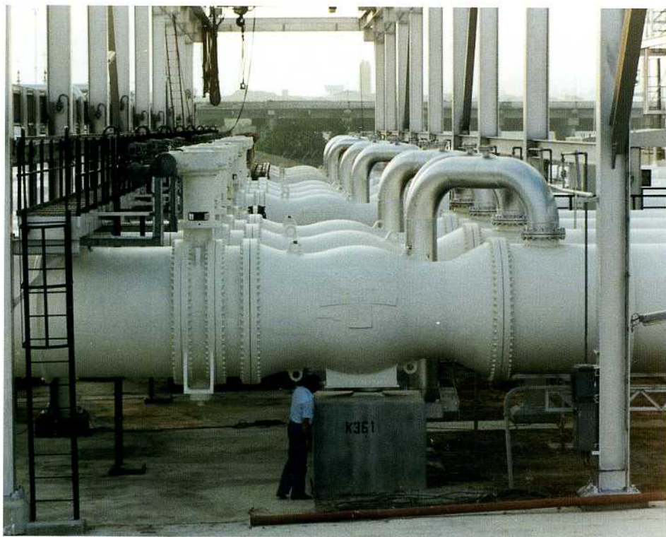
Безударные обратные клапаны 72" ANSI 175 на нагнетании насоса водоохлаждения установки сжижения природного газа, Малайзия
