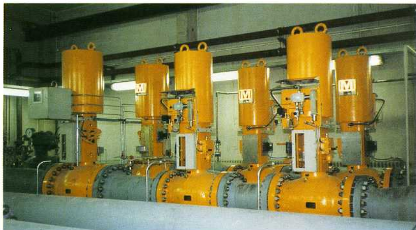
Регулирующие клапаны 20" ANSI 600 фунтов, предохранительные отсечные клапаны 16" ANSI 600 фунтов, измерительно-регулирующая станция, Германия.
