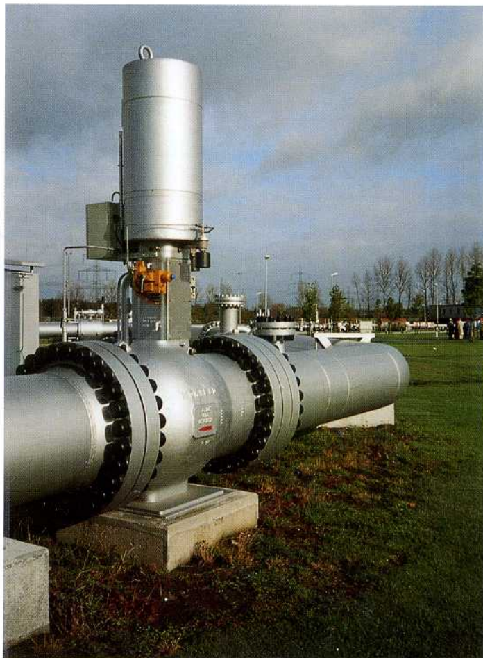
Клапаны HIPPS 28" ANSI 600 фунтов, вспомогательная компрессорная установка для природного газа, Германия
