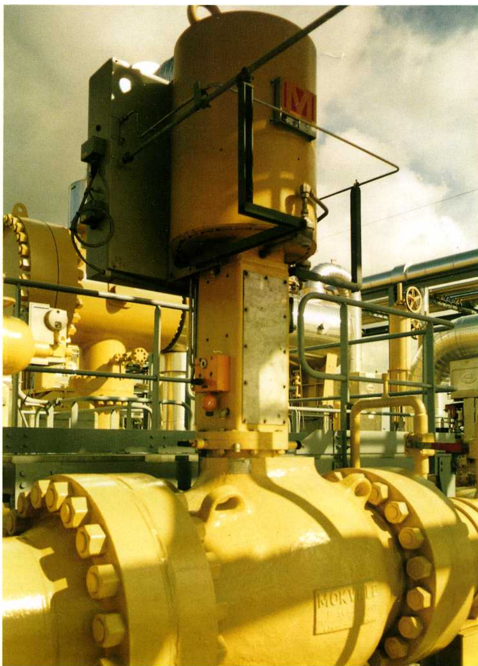
Клапаны HIPPS 16" ANSI 1500 фунтов на компрессорной станции в Германии
