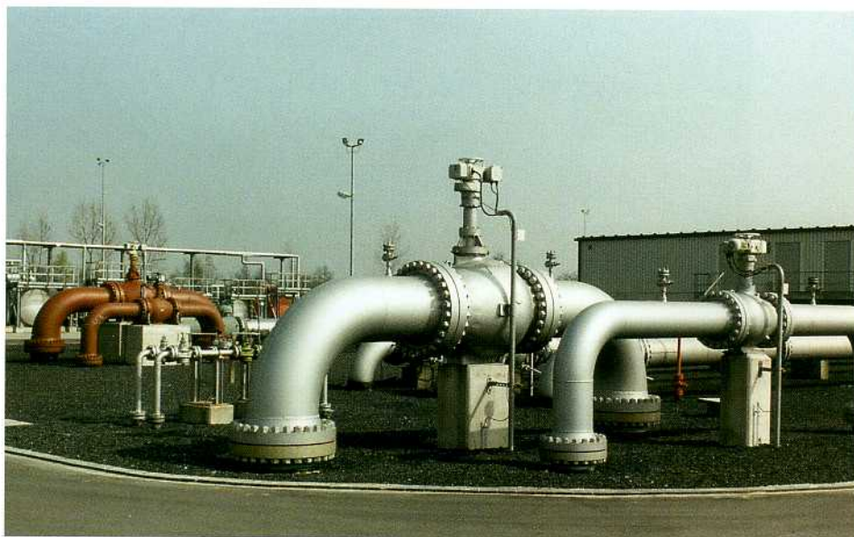
Клапаны регулирования расхода на подземном хранилище газа, Германия
