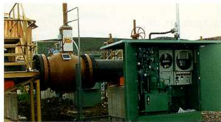
Клапаны редуцирования давления 20" ANSI 900 на газовом терминале, Малайзия
